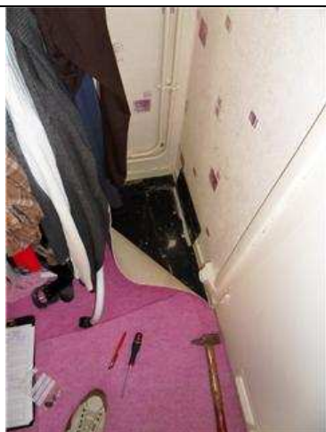
007 - Appartements - Chambre LOT 0002 PH21 : Dalle, colle, ragréage PRE021
