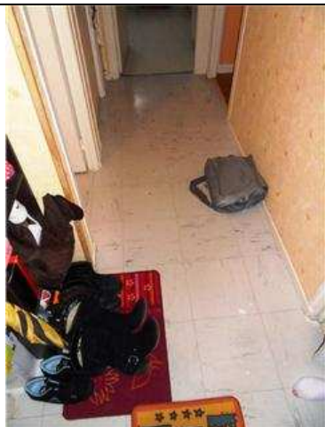
001 - Appartements - Entrée LOT 0002 PH19 : dalles de sol PRE019
