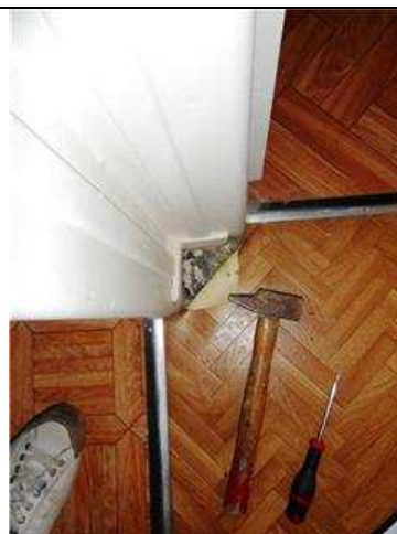
008 - Appartements - Entrée LOT 0001 PH22 : Dalle, colle, ragréage PRE022
