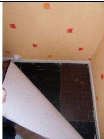
006 - Appartements - Séjour LOT 0002 PH20 : dalles de sol PRE020
